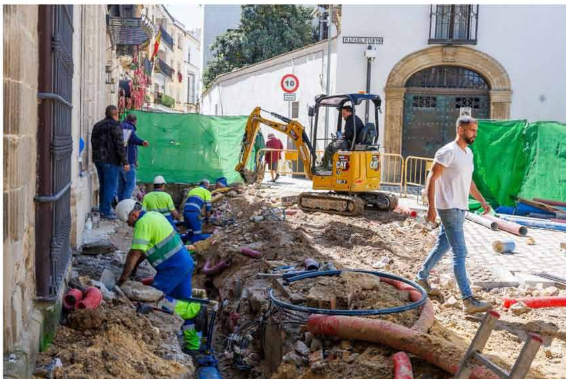
Operarios de Aquajerez trabajan en la finalización de los trabajos en plaza Rafael Rivero en Jerez, este pasado miércoles.
