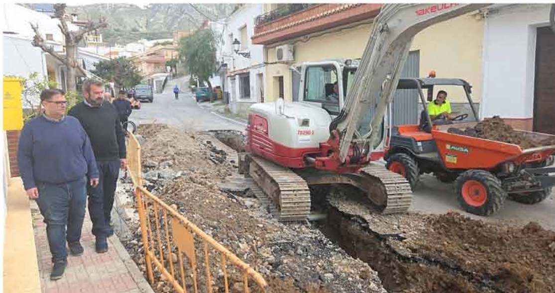
Visita a los trabajos que se están realizando en Lentegí / G.H.
