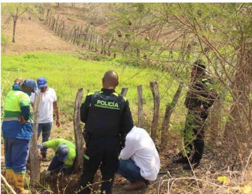
En esta finca del municipio de Candelaria se encontró una tubería ilegal.
