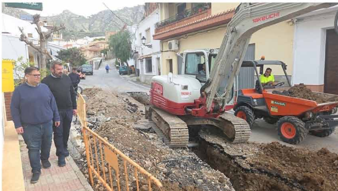
Visita a las obras de Lentegí (MANCOMUNIDAD)
