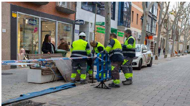
Cuatro operarios trabajan en la zona del atasco en la calle Toledo. / TOMÁS FERNÁNDEZ DE MOYA
