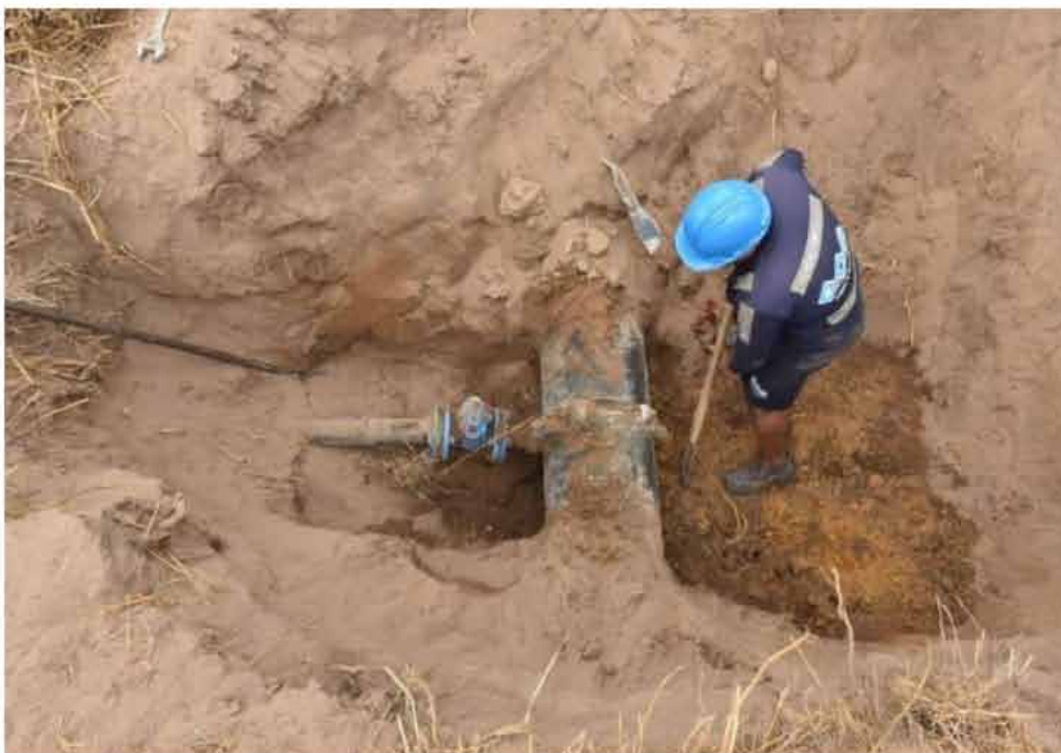
Operarios de la Triple A en trabajos de desconexión de tuberías ilegales.
